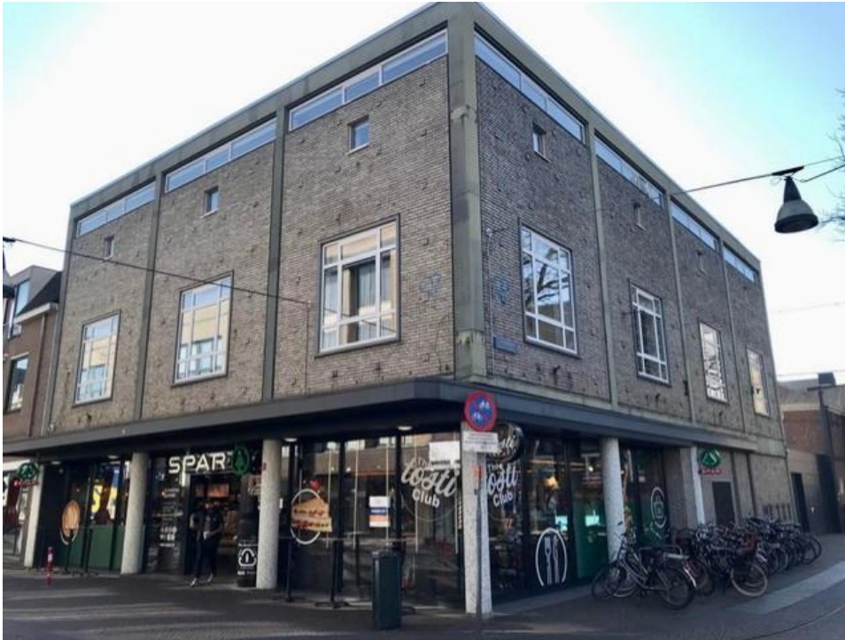
Figuur 2 Transformatie boven de Spar City aan de Marktstraat in Enschede (bron: Bovendewinkel)
